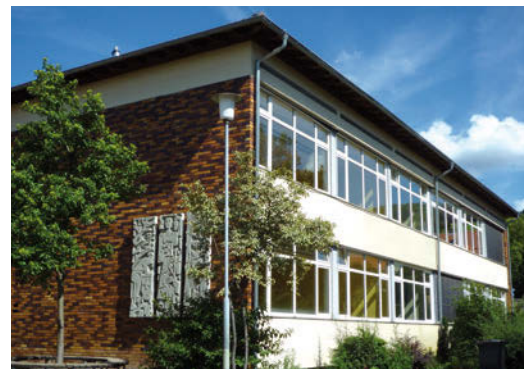
Schulhaus der Außenstelle Britzingen
